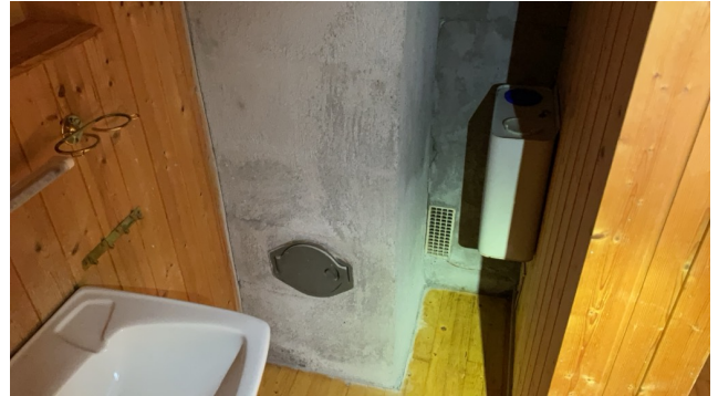
Avstand til brennbart materiale fra sotluke er for kort til vegg og gulv, sprekk i pipe fra vaskerom.
