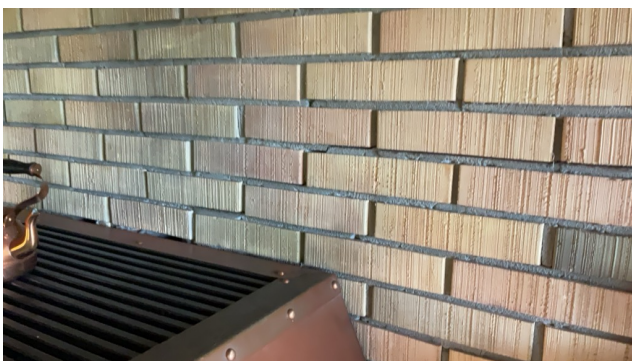
Sprekk i brannmur, årsak er setninger i bygning
