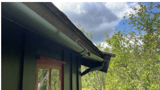
Manglende bortledning av takvann, bør ledes vekk fra bygnings kropp
