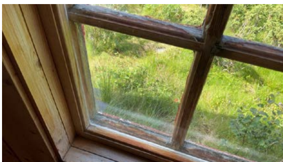
Vinduer er preget av elde og vedlikeholdsetterslep, vedlikehold eller utskifting må foretas
