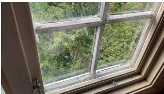
Vinduer er preget av elde og vedlikeholdsetterslep, vedlikehold eller utskifting må foretas
