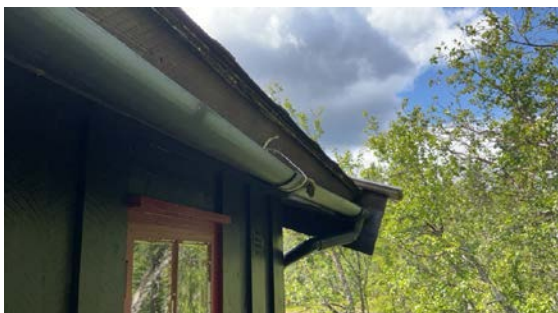
Manglende bortledning av takvann, bør ledes vekk fra bygningskropp
