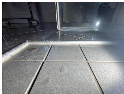
Nedsenket gulv i nisje
