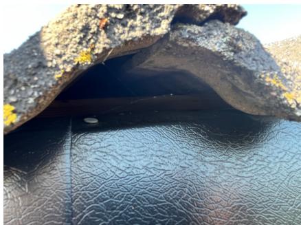
Mangler fuglelist under stein
