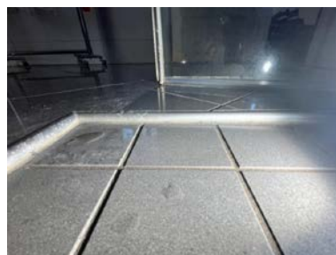
Nedsenket gulv i nisje
