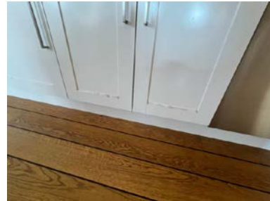
Fuktsvelling på fronter
