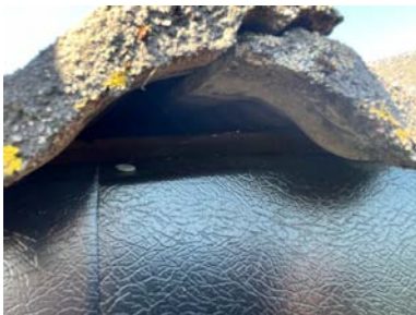
Mangler fuglelist under stein
