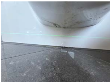
Drenering fra innebygd vannsisterne
