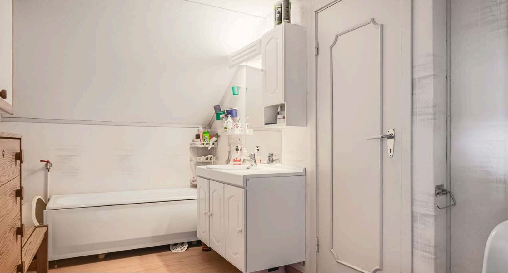
Bad i 2. etasje med adkomst fra den ene stua. Badet har belegg på gulvet og vinyltapet på veggene. Det er utstyrt med gulvmontert toalett, badekar og baderomsinnredning med servant.
