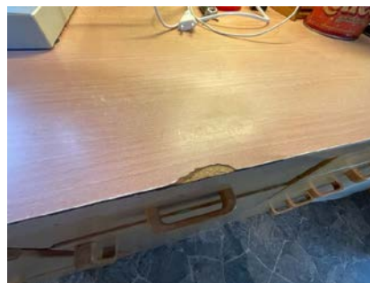
Skade benkeplate
