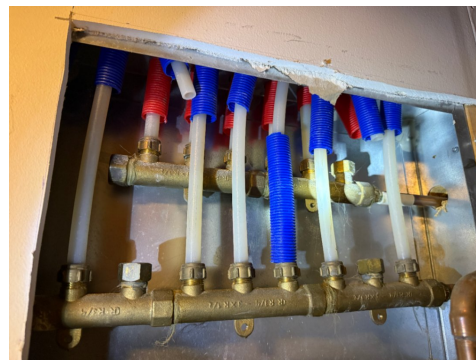
Bod/teknisk rom kjeller
