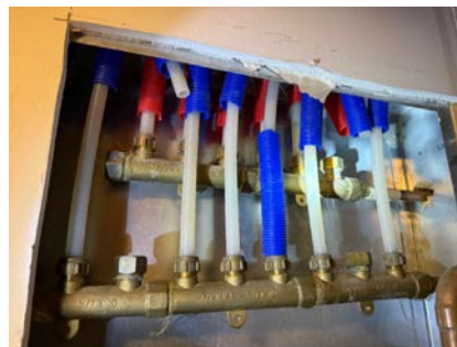
Bod/teknisk rom kjeller
