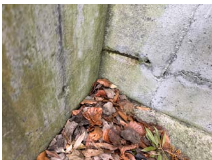
Støttemur kjeller vange
