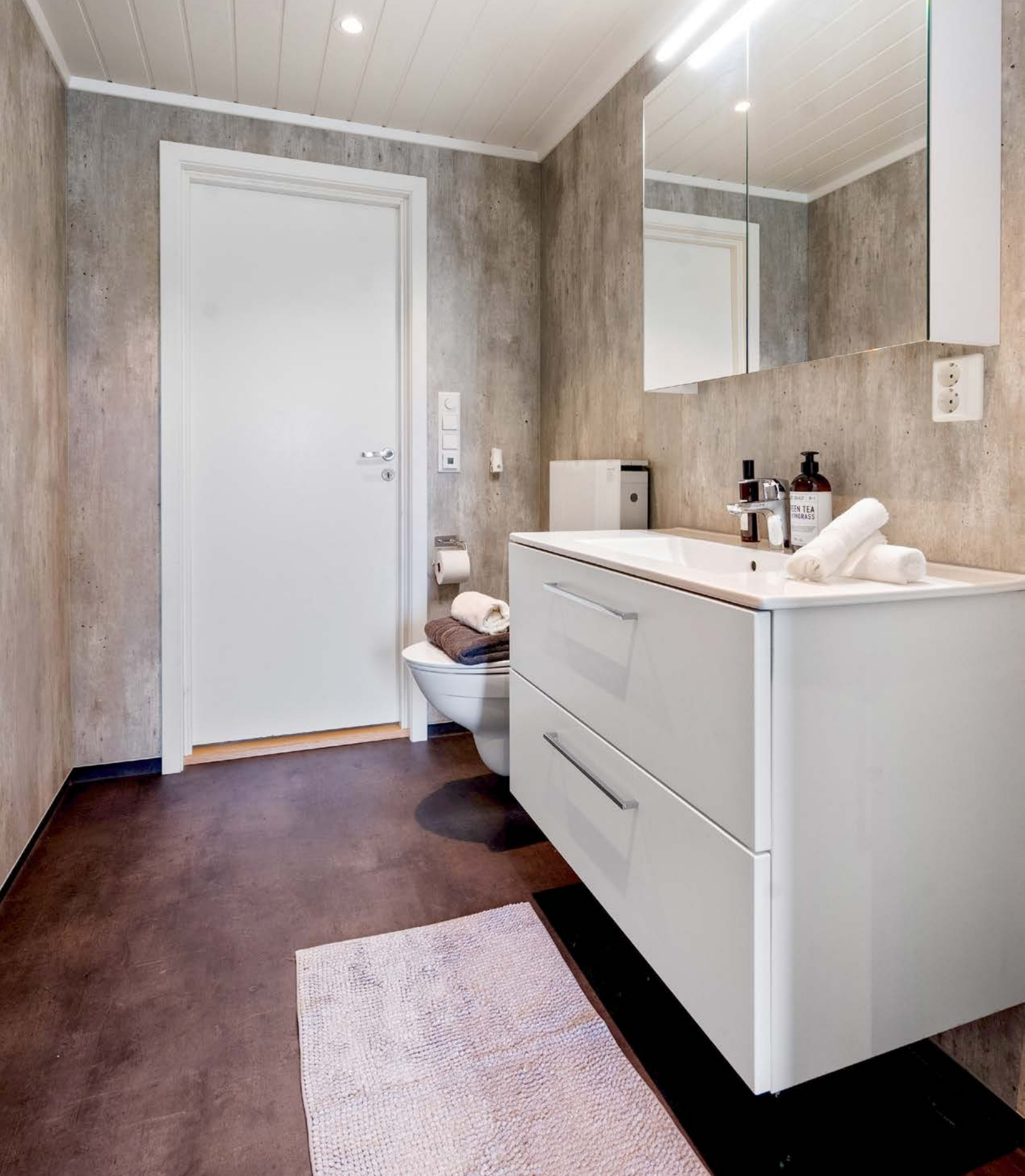
Pent bad fra 2021 med belegg på gulvet og baderomsplater på veggene. I gulvet er det varmekabler.
