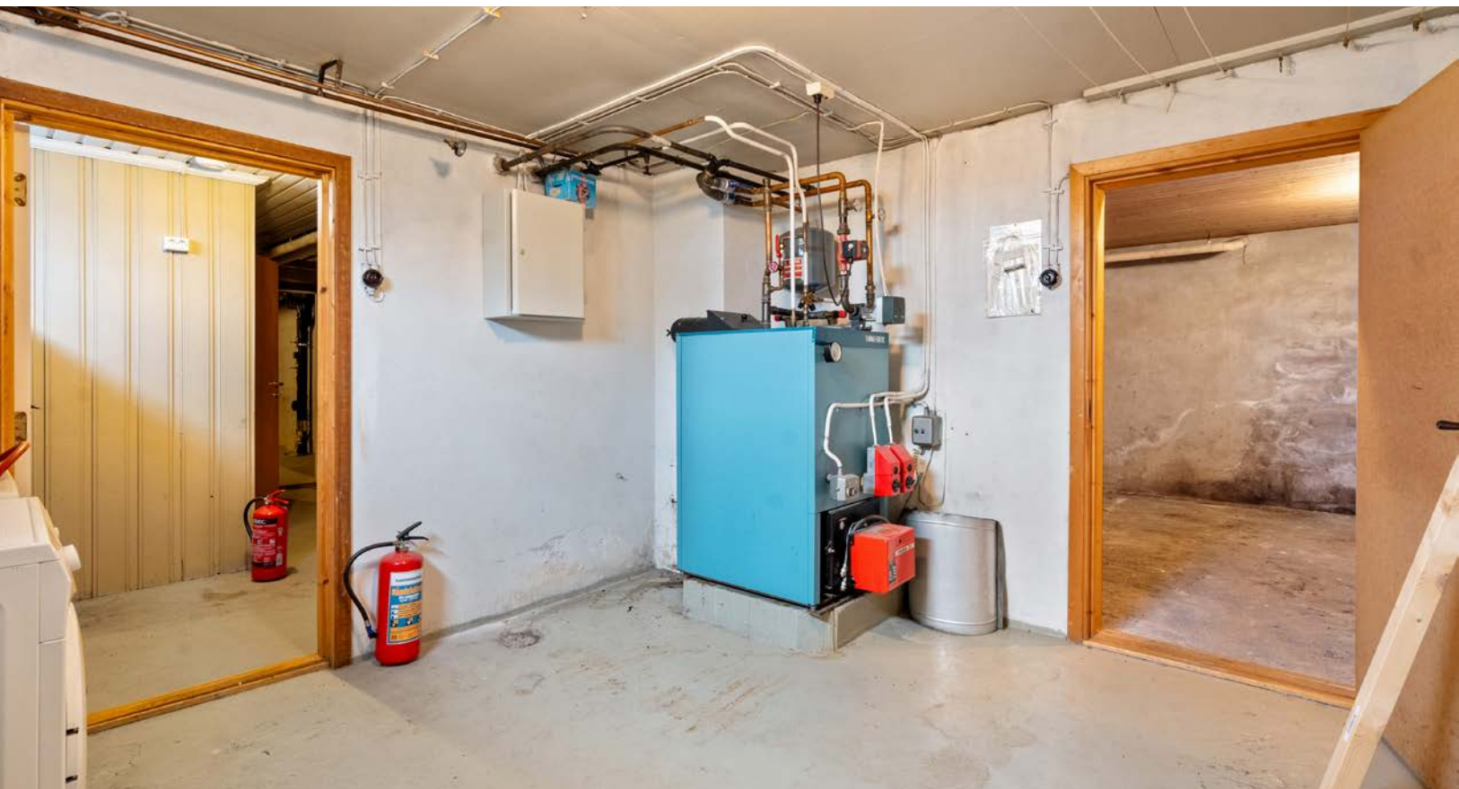
I kjelleren er det garasje og flere bodrom.
