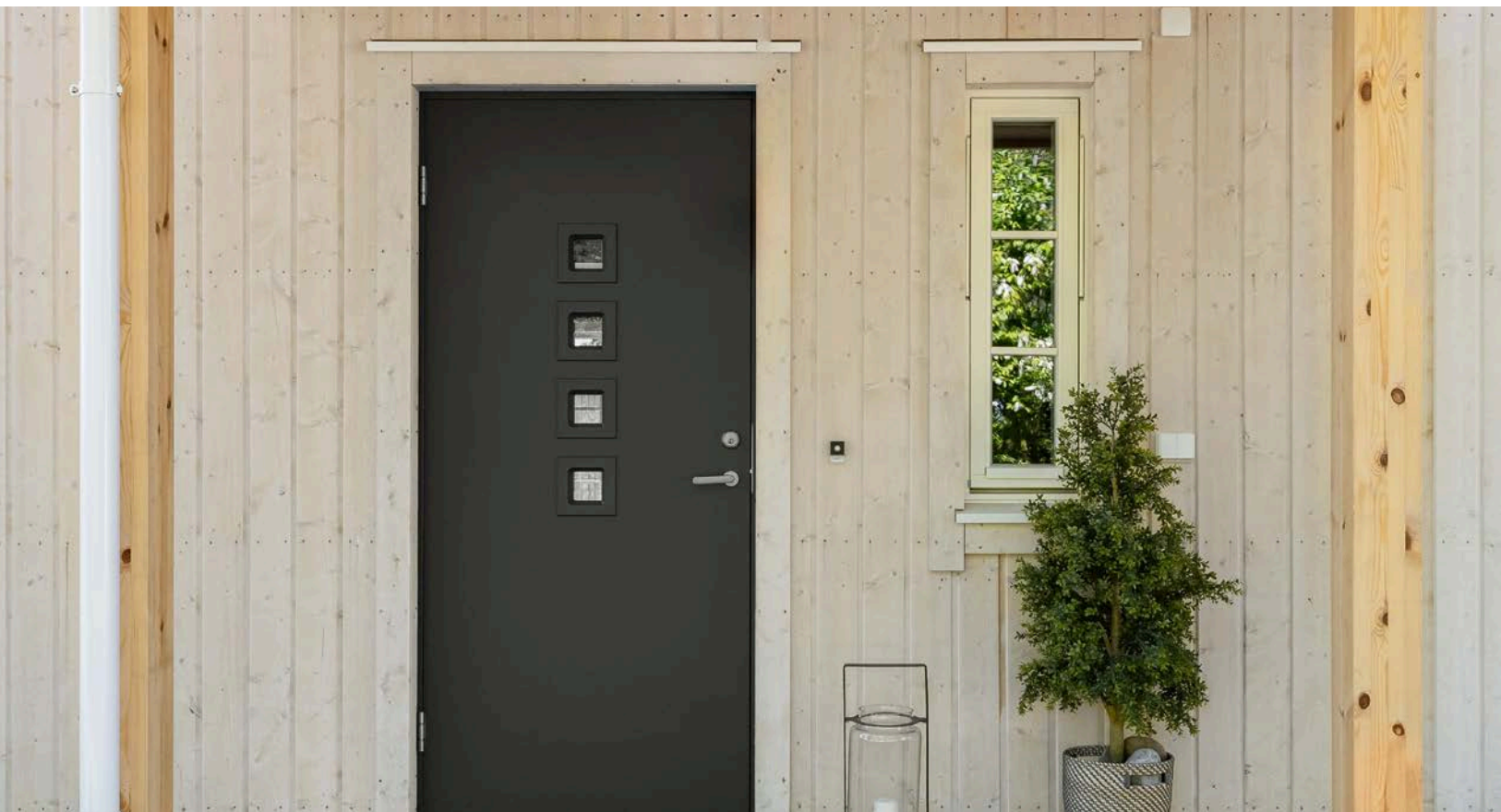
Overbygd inngangsparti med terrasseplattning.
