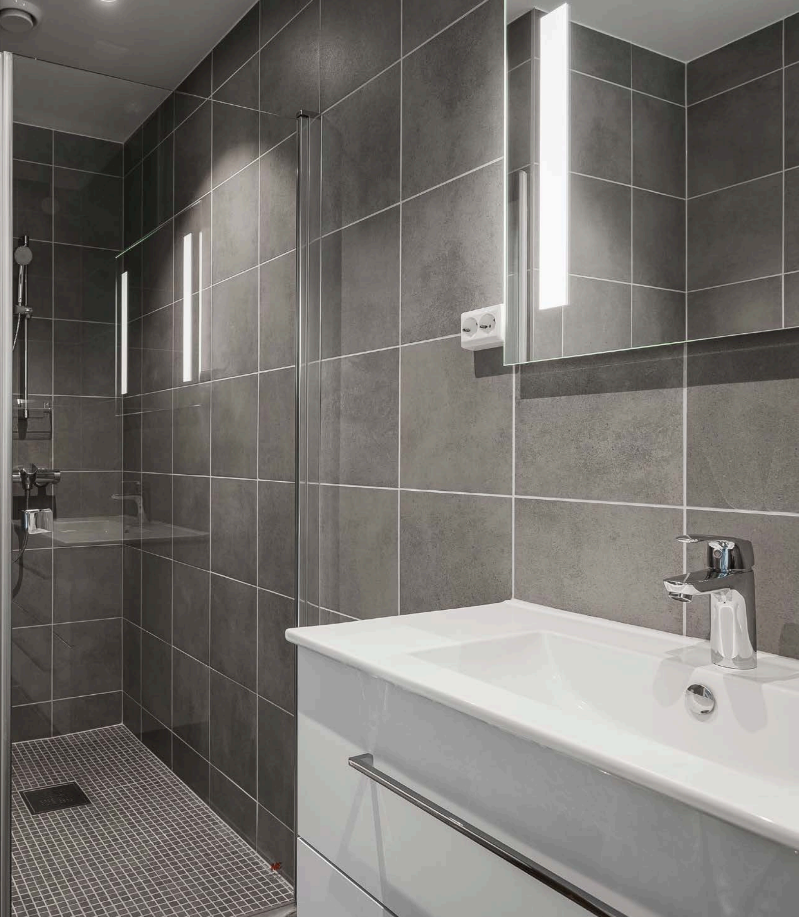
Bad i 1. etasje med flislagte gulv og vegger. Servant på underskap med speil og belysning over. Dusjhjørne med glassdør og mosaikkfliser på gulv. Vegghengt toalett.
