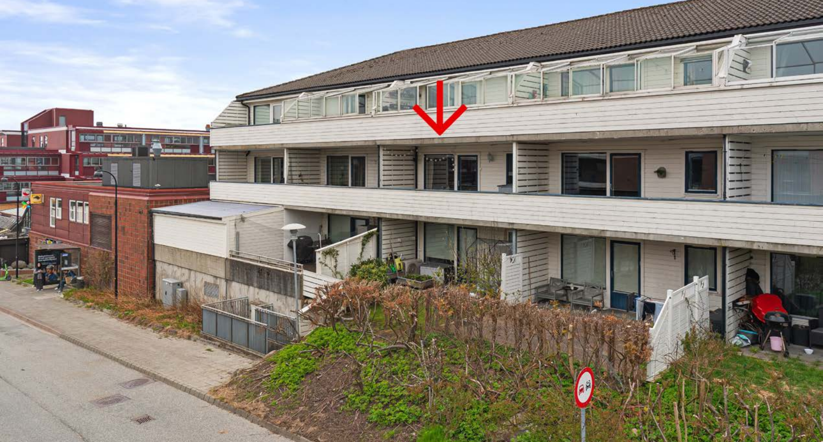
Leiligheten ligger i 2.etasje og har gode solforhold
