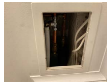
Rør-opplegg i tak i bad.
