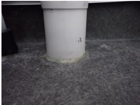
Ikke tilstrekkelig krymping av belegg.
