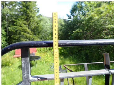
Rekkverkshøyde, strekkmetalltrapp.
