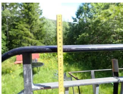
Rekkverkshøyde, strekkmetalltrapp.
