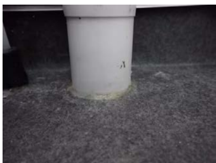
Ikke tilstrekkelig krymping av belegg.
