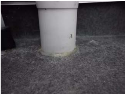
Ikke tilstrekkelig krymping av belegg.
