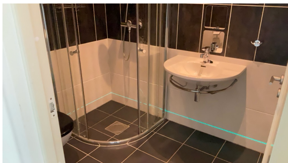
Bad i leilighet mot øst.
