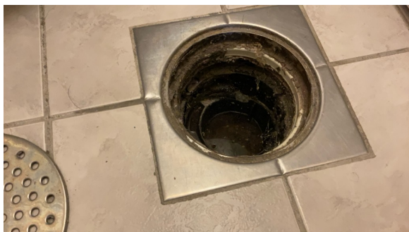
Sluk i vaskerom
