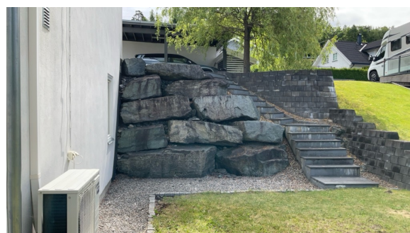
Natursteinmur uten rekkverk.
