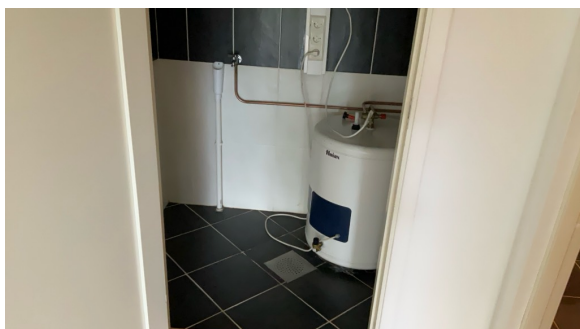
Vaskerom i leilighet mot øst.
