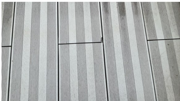
Gliper i skjøter på komposittgulv.
