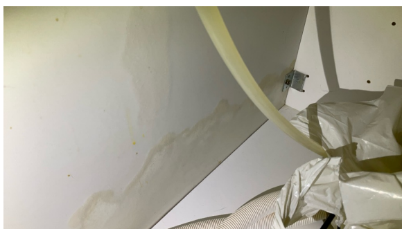
Fuktmerker på skrog.
