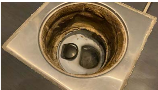
Sluk i dusjsonen
