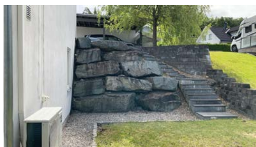
Natursteinmur uten rekkverk.
