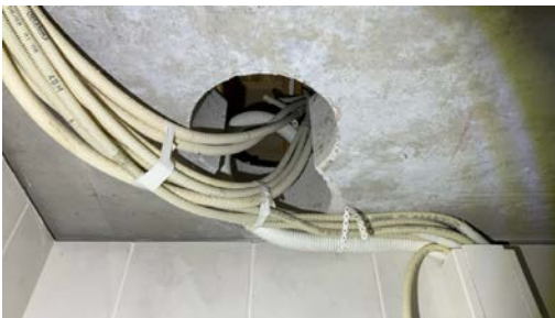
Hull i betongtak opp til hoveddel.
