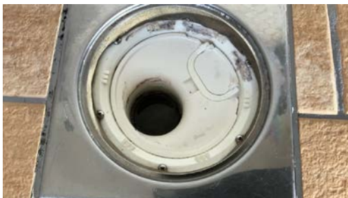
Sluk i dusjsonen
