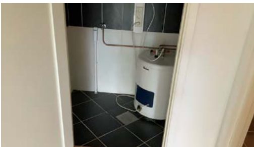
Vaskerom i leilighet mot øst.
