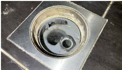
Sluk i gulv på vaskerom.
