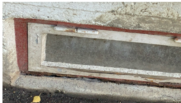
Råte i vinduskarm for kjellervindu på grunn av manglende beslag som beskytter mot fukt.
