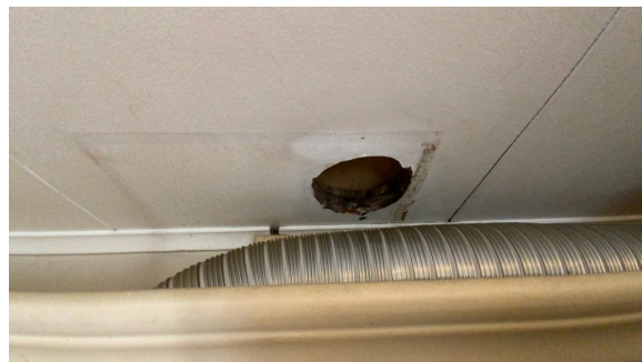
Tidligere avtrekkskanal er tettet.
