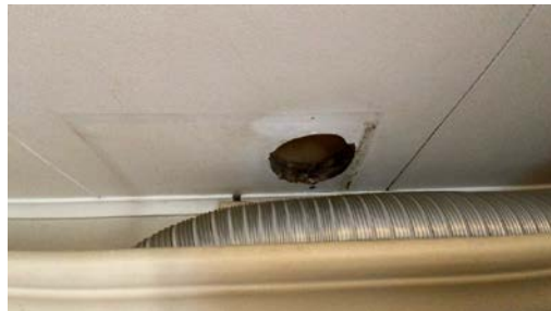
Tidligere avtrekkskanal er tettet.
