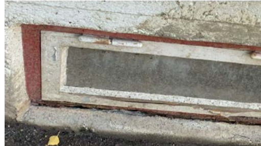
Råte i vinduskarm for kjellervindu på grunn av manglende beslag som beskytter mot fukt.
