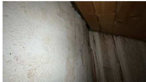
Råte i vinduskarm for kjellervindu på grunn av manglende beslag som beskytter mot fukt.
