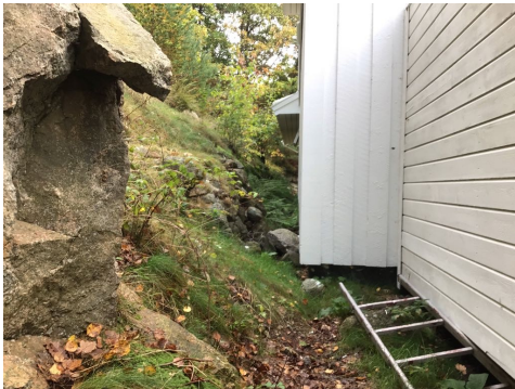
Fall mot grunnmuren
