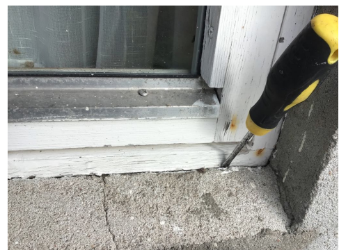
Åpning under vindu i kjelleren
