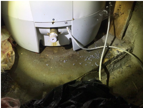
Vann under varmtvannstanken
