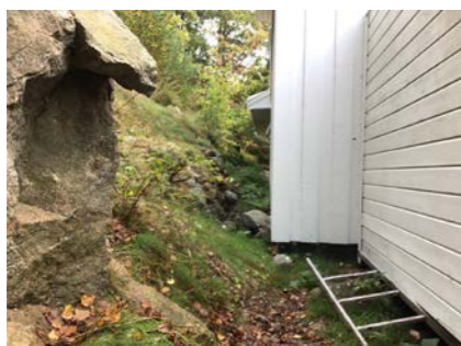
Fall mot grunnmuren
