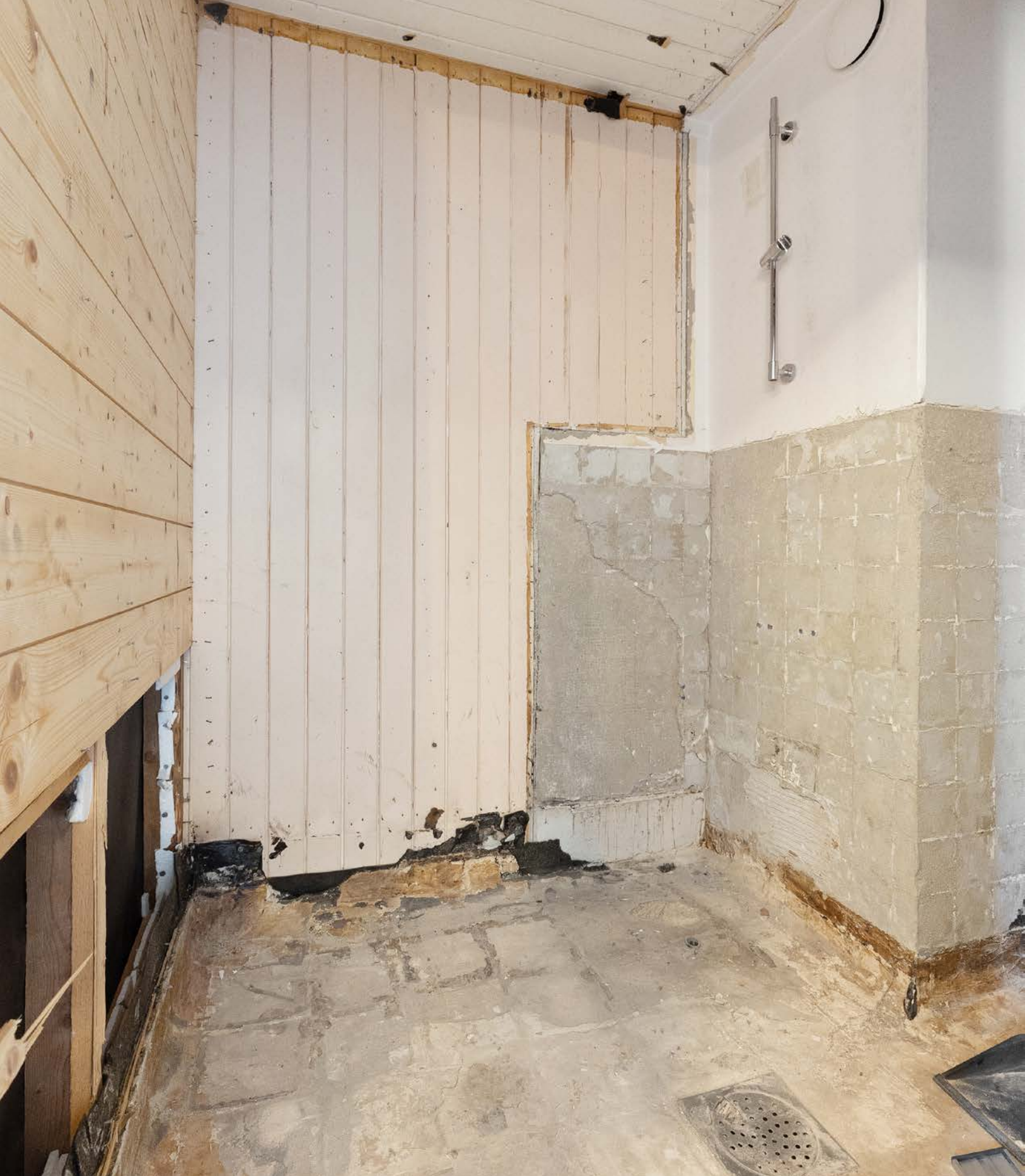
Uinnredet rom med gulvsluk på betonggrunn. (tidligere bad som er revet).
