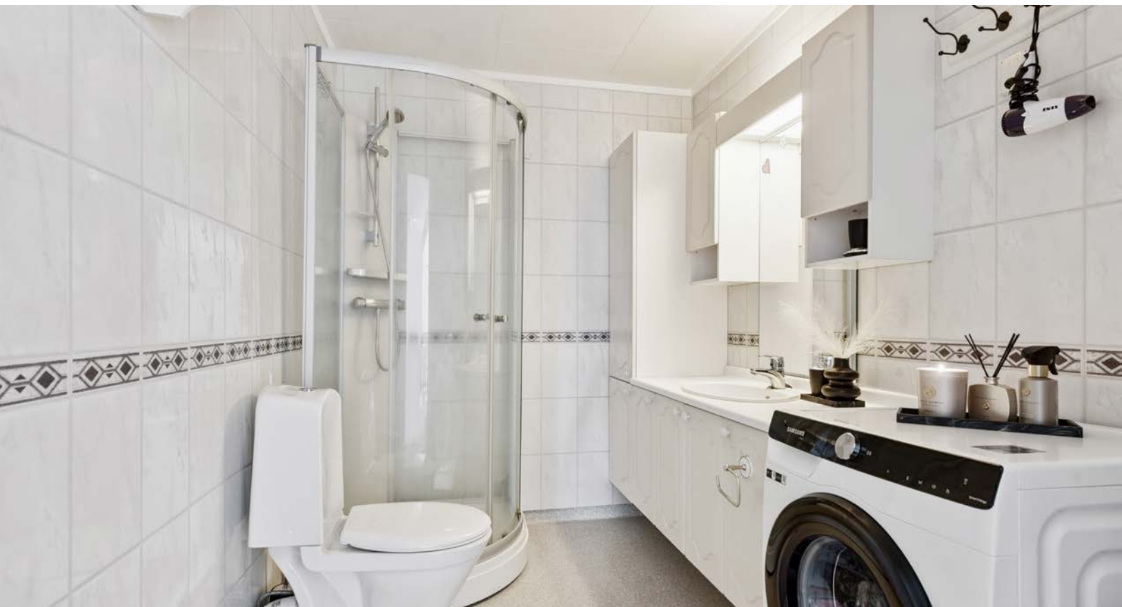
Bad/vaskerom med vinylbelegg med varme på gulv, våtromsplater på vegger og tak-ess i tak.
