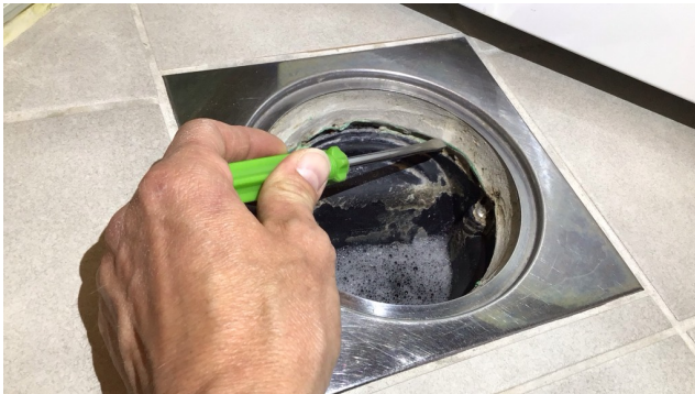
Bildet viser sluket ved vaskemaskin.
