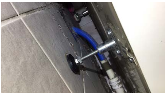
Bildet viser sluket under dusjkabinettet.
