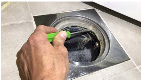
Bildet viser sluket ved vaskemaskin.
