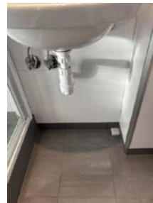
Lekkasjestopper som stenger av vannet ved en lekkasje.
