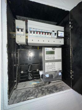
Sikringsskap med automatsikringer.
