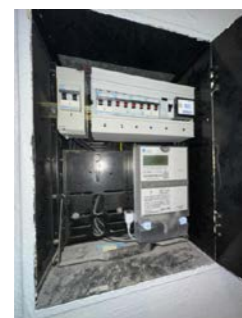
Sikringskap med automatsikringer.
