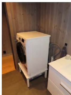
Del av bad/vaskerom. Vann og avløpsuttak for vaskemaskin.
