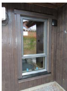
Åpningsvindu med fastkarm nedre del.
