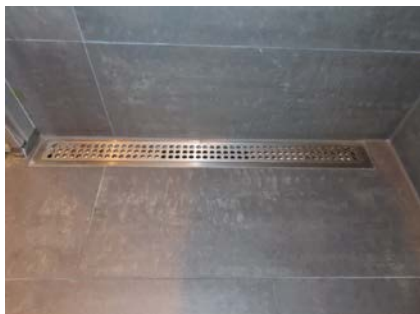
Slukrenne i dusj - Puruslukk med flersjikt oppbygging, hvor det ihht alder og tekniske forskrifter ved byggeår forutsettes at det er lagt/benyttet mansjett i sluk, hvor denne følger anvisningene og er lagt ned under klemring.
