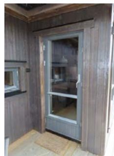
Terrassedør som utadslående fra stue til markterrasse.
