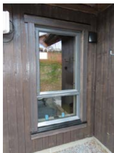
Åpningsvindu med fastkarm nedre del.
