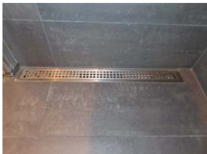
Slukrenne i dusj - Purussluk med flersjikts oppbygging, hvor det ihht alder og tekniske forskrifter ved byggeår forutsettes at det er lagt/benyttet mansjett i sluk, hvor denne følger anvisningene og er lagt ned under klemring.
