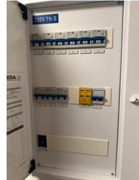
Sikringsskap med automatsikringer.
