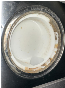
Plastsluk med klemring for membran
