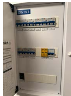
Sikringssskap med automatsikringer.
