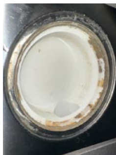
Plastsluk med klemring for membran
