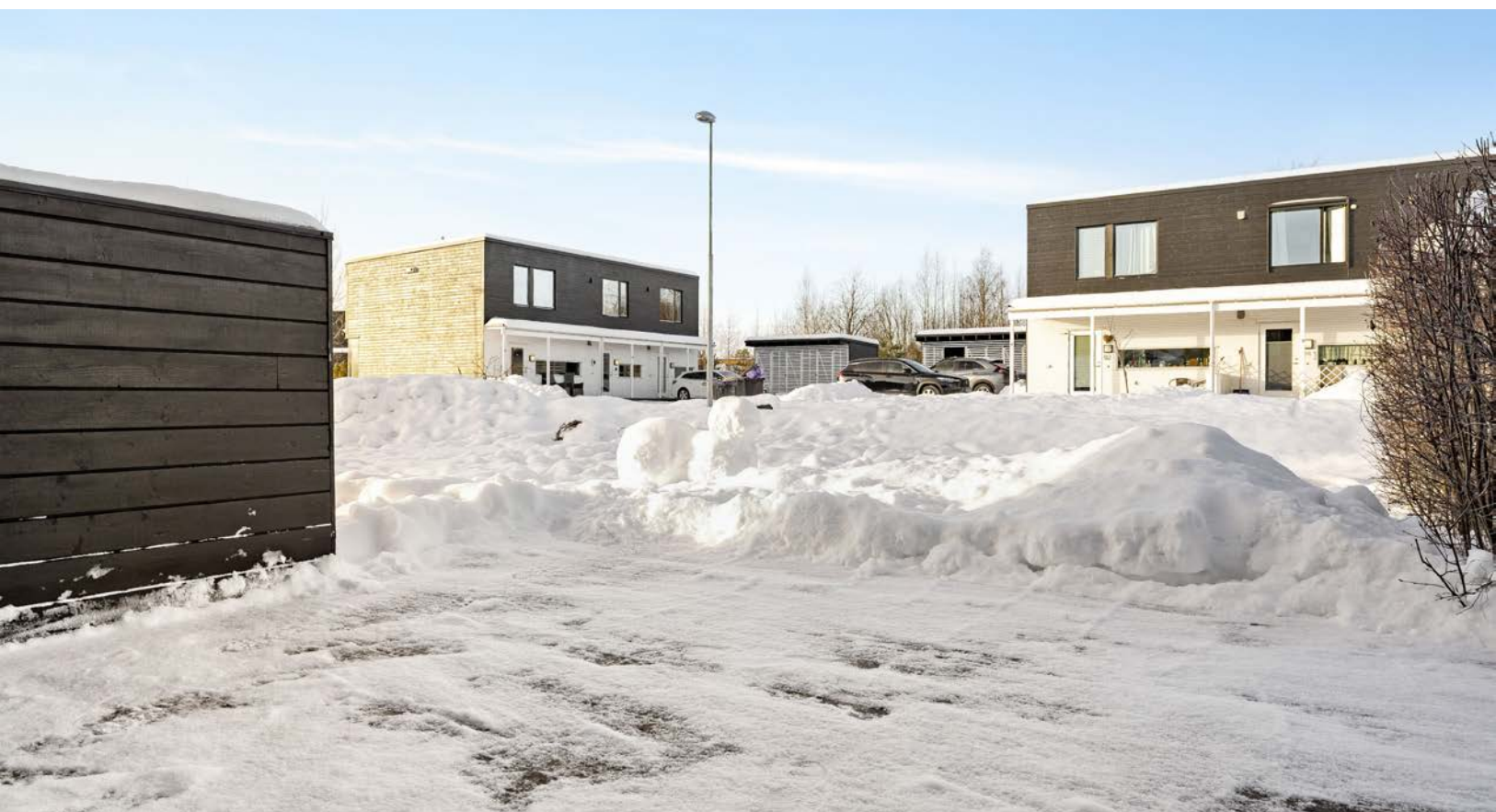
Felles parkeringsplass for sameiet. Plassen er nyasfaltert i 2025.
