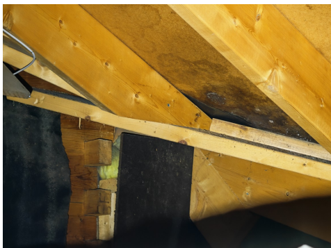
Takkonstruksjon kontrollert fra luke inngangsdør.
