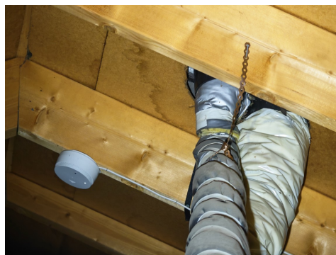
Takkonstruksjon kontrollert fra luke inngangsdør.
