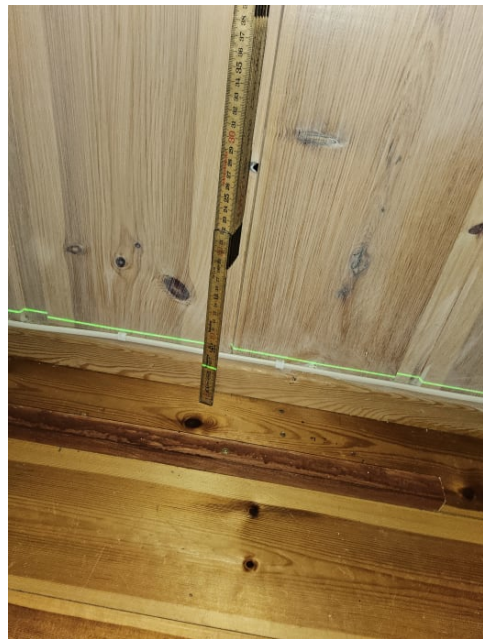
Bilde viser måling av etasjeskiller.
