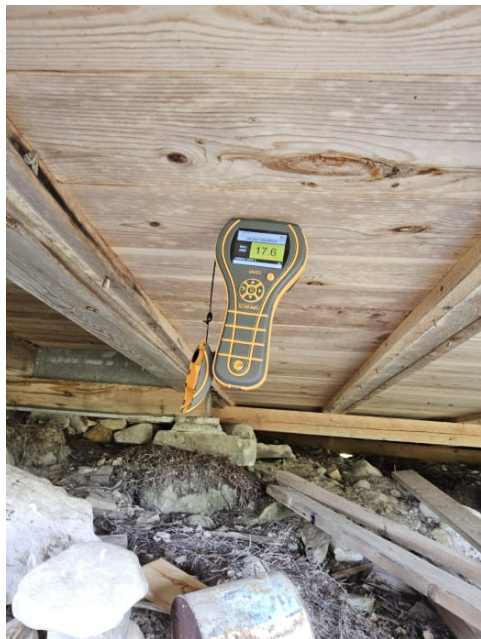
Bilde viser fuktmåling i kryprom.
