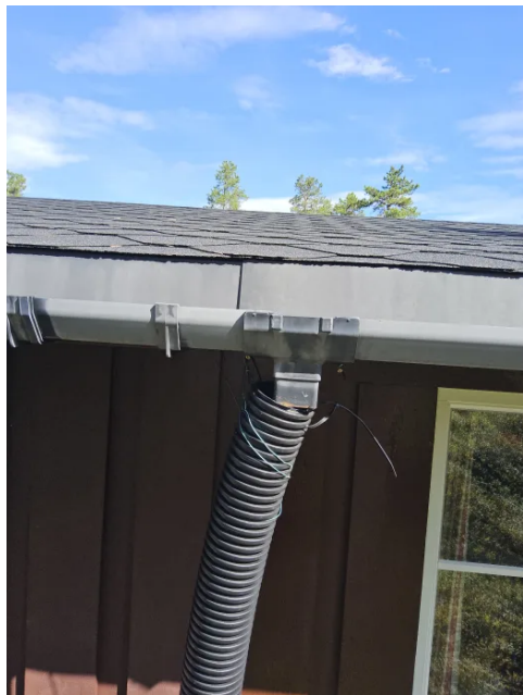
Bilde viser takrenne og taknedløp.
