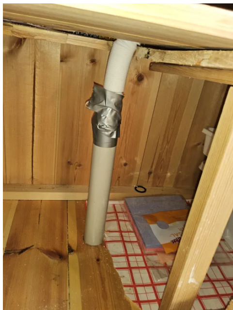
Bilde viser avløpsrør.
