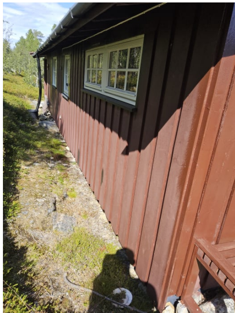
Bilde viser kledning ført ned mot terreng.
