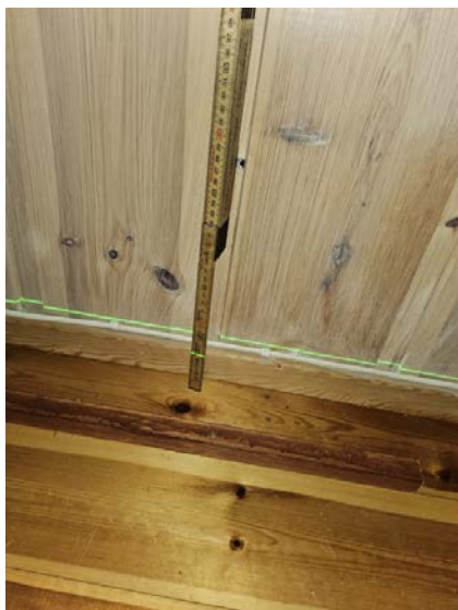
Bilde viser måling av etasjeskiller.
