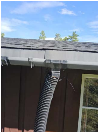
Bilde viser takrenne og taknedløp.
