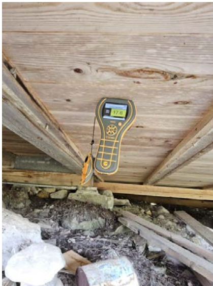
Bilde viser fuktmåling i kryprom.
