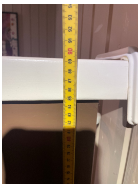
Høyde rekkverk trapp under 90 cm
