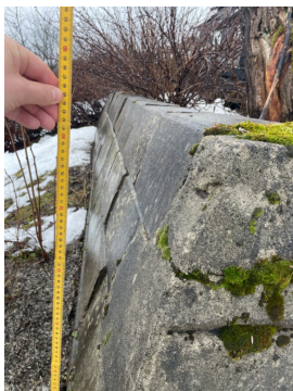
Åpning mellom trinn over 10 cm
