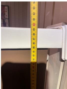
Åpning mellom trinn over 10 cm
