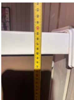
Høyde rekkverk trapp under 90 cm
