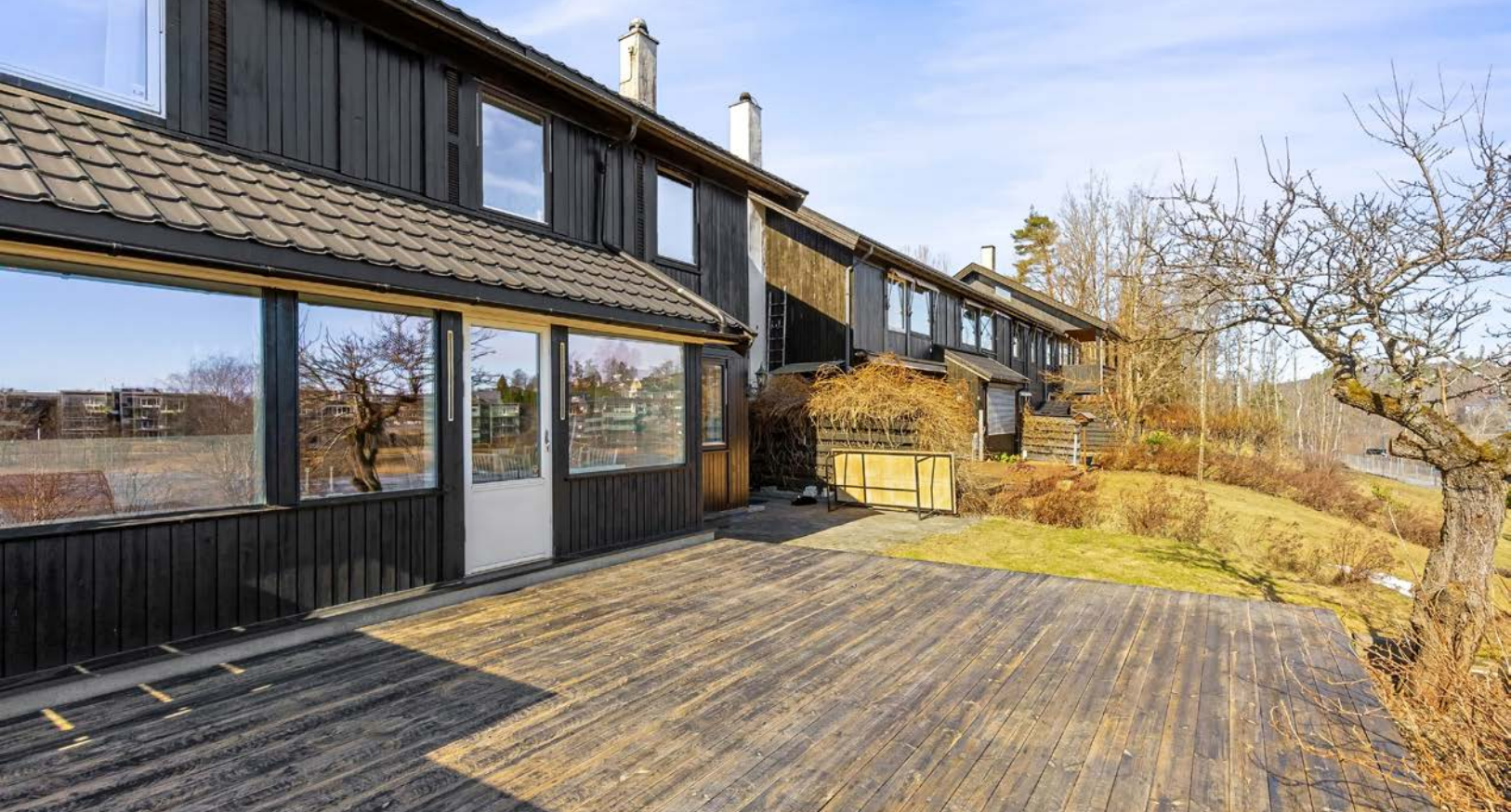
Ytterveggen mot stuen, vinduer og terrassedør ble byttet i 2011.
