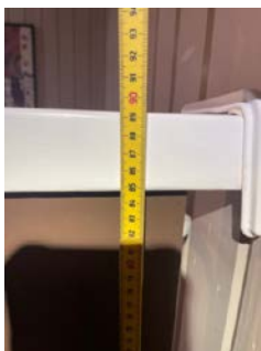
Åpning mellom trinn over 10 cm
