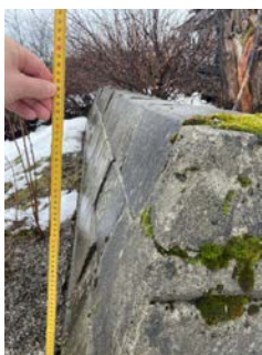
Åpning mellom trinn over 10 cm
