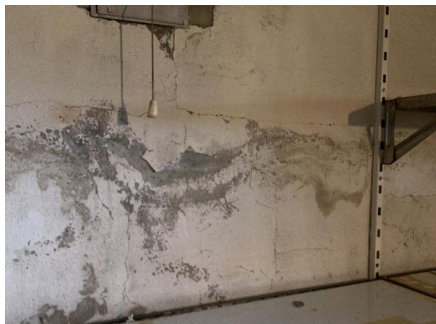
Eksempel på avskaling på vegger.
