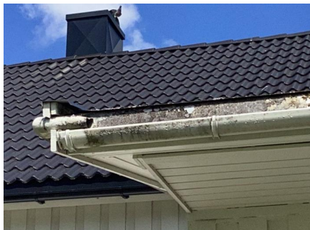
Eksempel på misfarging på takrenne og takfotbeslag.
