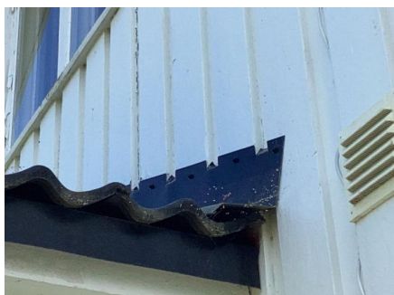
Beslag over entre er lagt utenpå fasadekledning.
