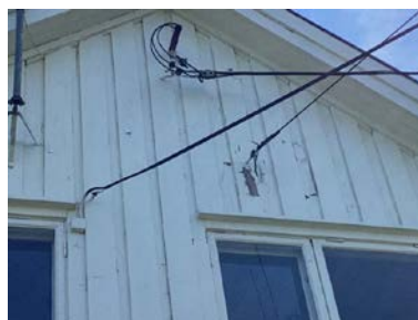
Eksempel på avskaling av maling.
