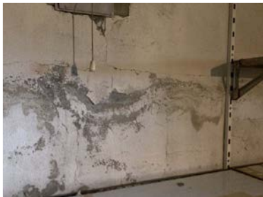
Eksempel på avskaling på vegger.
