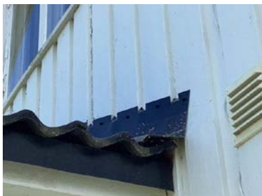
Beslag over entre er lagt utenpå fasadekledning.
