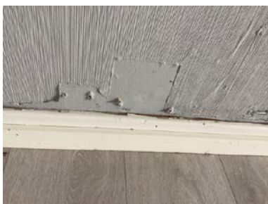
Eksempel på utsparing i tapet.
