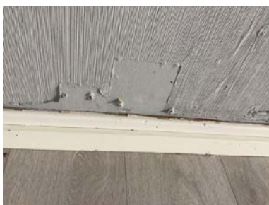
Eksempel på utsparing i tapet.
