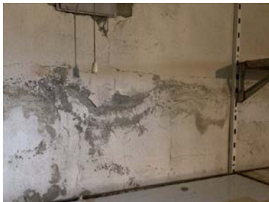
Eksempel på avskaling på vegger.
