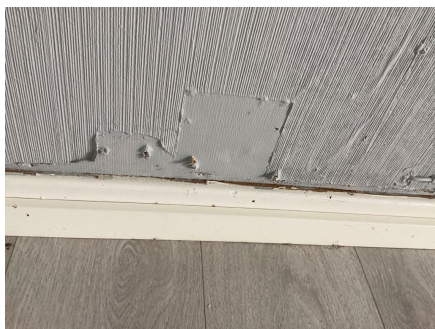
Eksempel på utsparing i tapet.
