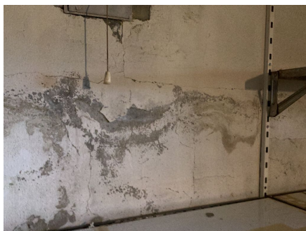
Eksempel på avskaling på vegger.
