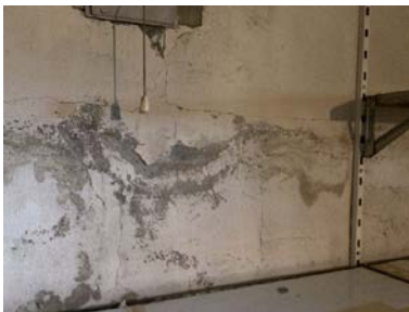
Eksempel på avskaling på vegger.
