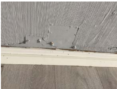
Eksempel på utsparing i tapet.
