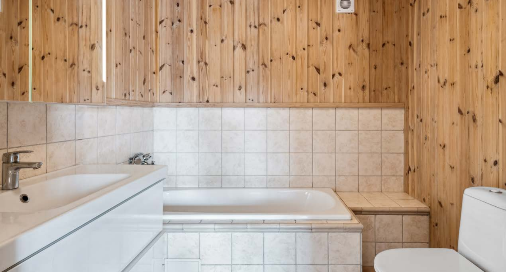
Baderommet som ble pusset opp i ca. 2005 har flislagt gulv med gulvvarme, overflater med fliser og panel, samt elektrisk styrt vifte.
