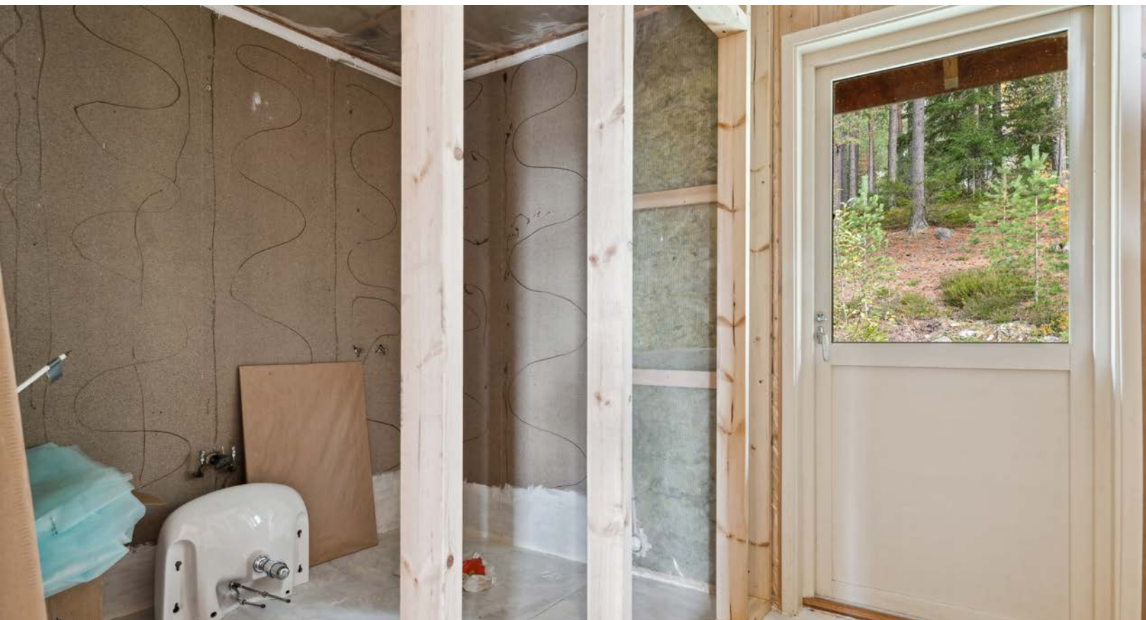
Entré i 1. etasje og rom tiltenkt som bad (ikke ferdigstilt).
