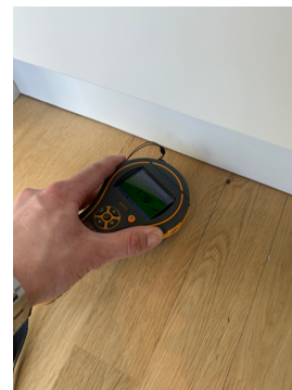
Tørre verdier i overflate ved oppvaskmaskin
