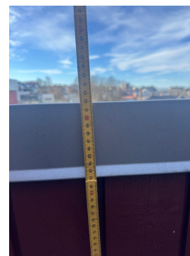
Høyde på rekkverk målt til 92cm
