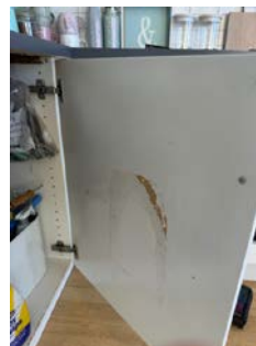
På innside av skapdør er skapdør skadet i overflaten.
