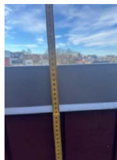
Høyde på rekkverk målt til 92cm
