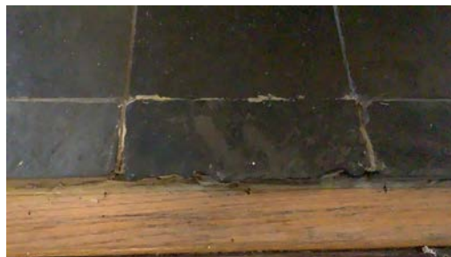
Sprang mellom gulvfliser i spisestue.
