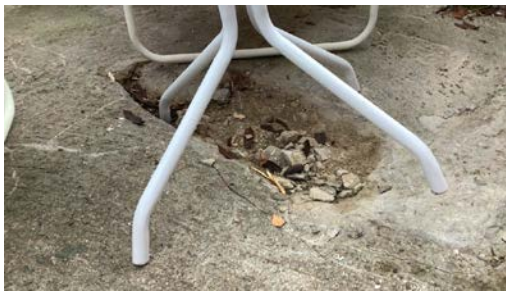
Sprekkdannelse i betongplate.
