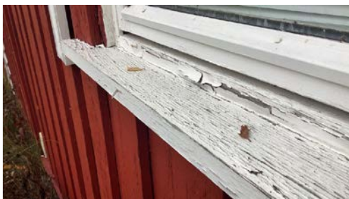
Vannbrett med fall mot vindu.
