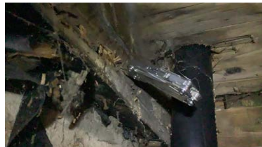
Råteskadet gulvbjelke.
